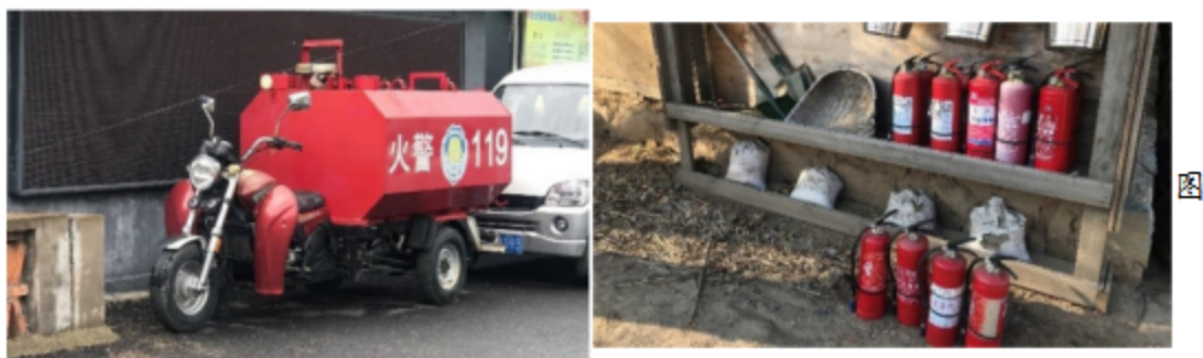
图2-20 村落消防设施
